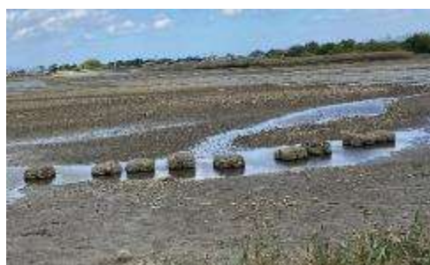
高尾野川に設置された石倉カゴ
