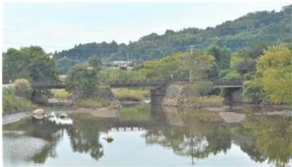
島津樋門全景
