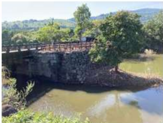
現在の島津樋門
